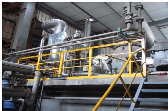
唐山春兴 2.24 MW 转炉蒸汽拖动二次除尘风机工程
