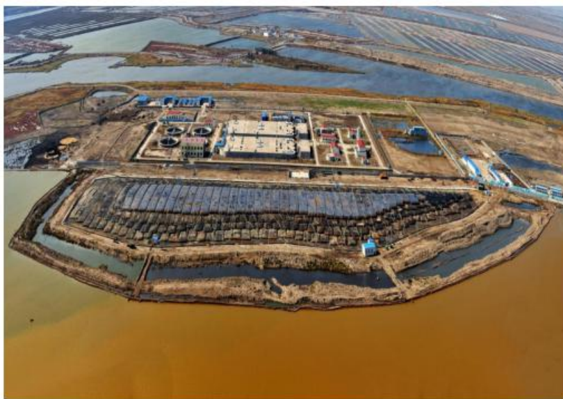
图 22 天津中新生态城污水库治理工程项目
