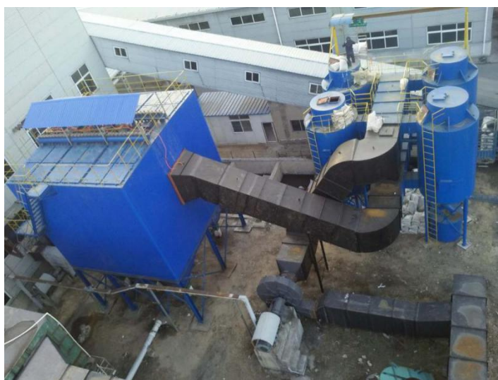
图 39 廊坊耀邦热力 35t/h 燃煤锅炉除尘脱硫脱硝改造项目
