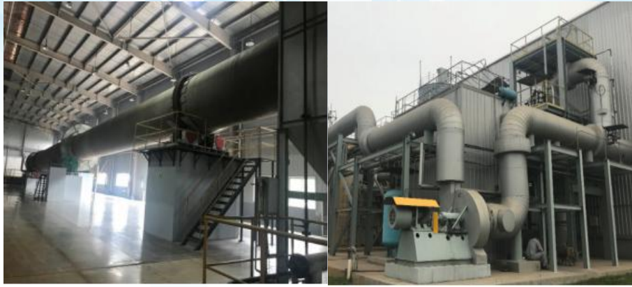
图 35 飞灰高温烧结回转窑系统（左）烟气处理系统（右）
