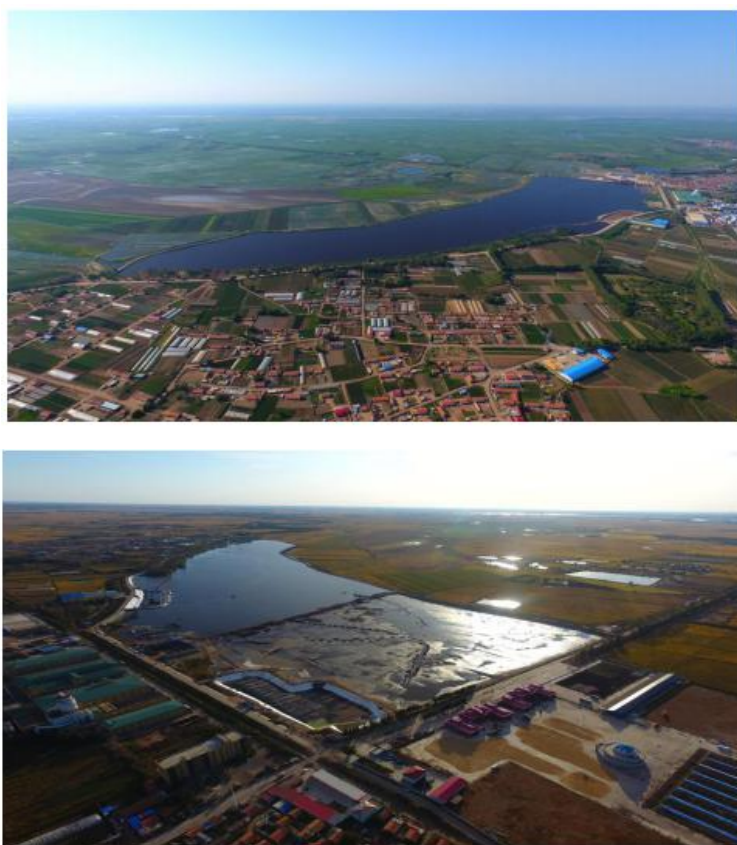
图 25 齐齐哈尔昂昂溪纳污坑塘黑臭水体治理工程
