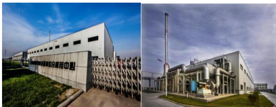
图 34 天津市固废集中处置与综合利用中心及飞灰烧结车间
