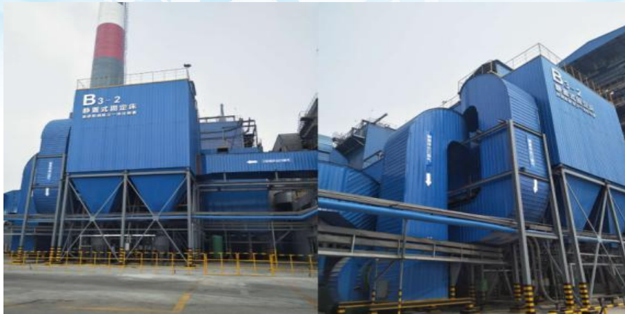
图 41 兖矿集团东华建设有限公司东滩矿电厂 3#锅炉改造项目
