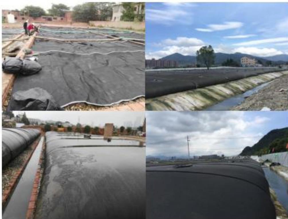
图 20 土工管袋脱水现场图
